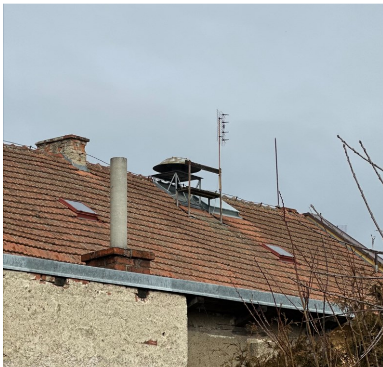
Obrázek 14) Rotační siréna na střeše hasičské stanice Sboru dobrovolných hasičů Kralice na Hané. [tvorba vlastní]
