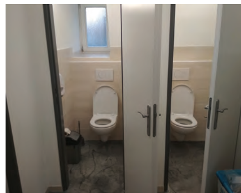
Opravy sociálního zařízení
