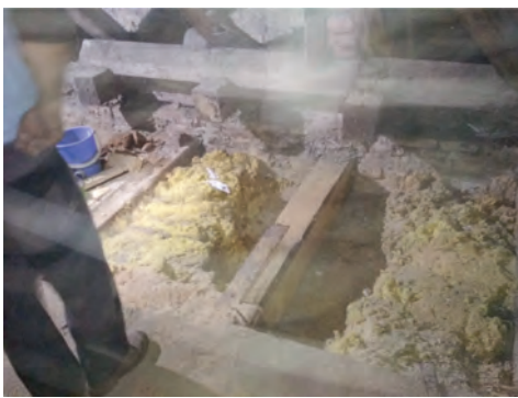
Oprava stropního trámu
