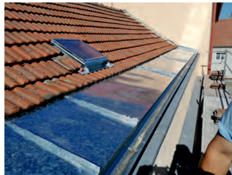
Oprava žlabu nad vstupem
