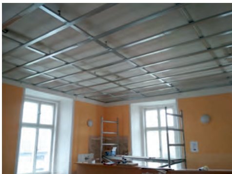
Zahájení - oprava stropu
