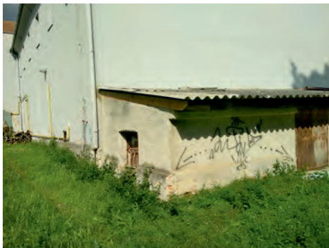
Příštěšek - oprava střechy
