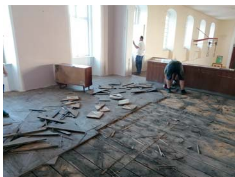
Rekonstrukce parketových podlah
