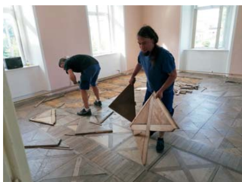
Rekonstrukce parketových podlah
